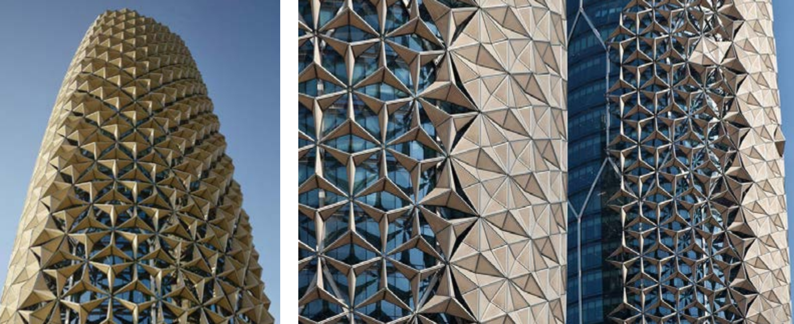
Al Bahr Towers, Abu Dhabi (2012). Sistema automatico di protezione dall'irraggiamento che consente l'abbattimento dei costi di condizionamento dell'ordine del 50%
