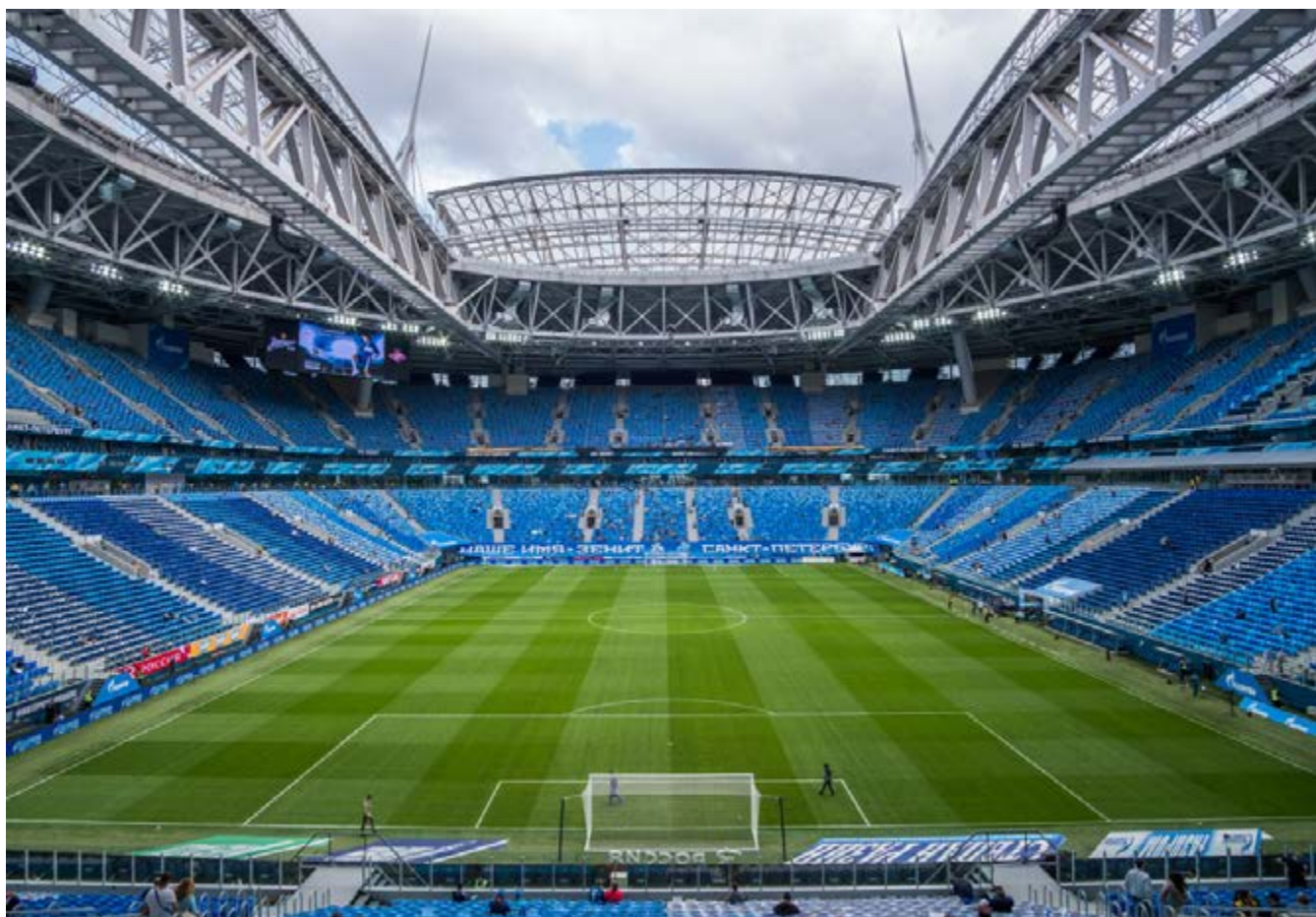
San Petersburg Stadium (2018) progettato da Kisho Kurokawa, è equipaggiato con la copertura mobile, il campo retrattile ed il sistema di condizionamento che consente il suo utilizzo polivalente durante l'anno.
